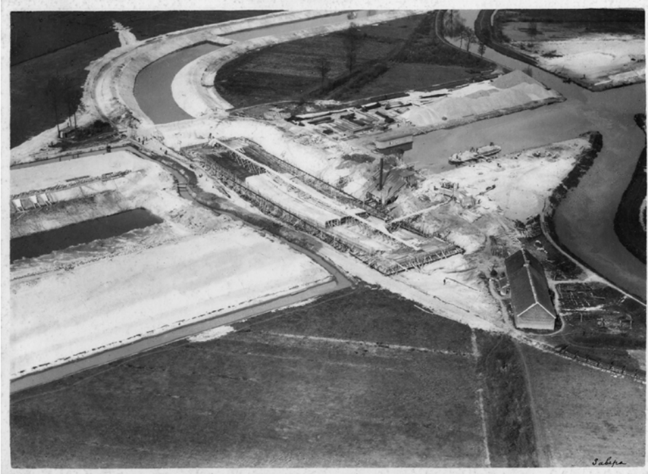
Sifoneren van de Kleine Nete (1928-1929) en aanleg Albertkanaal
