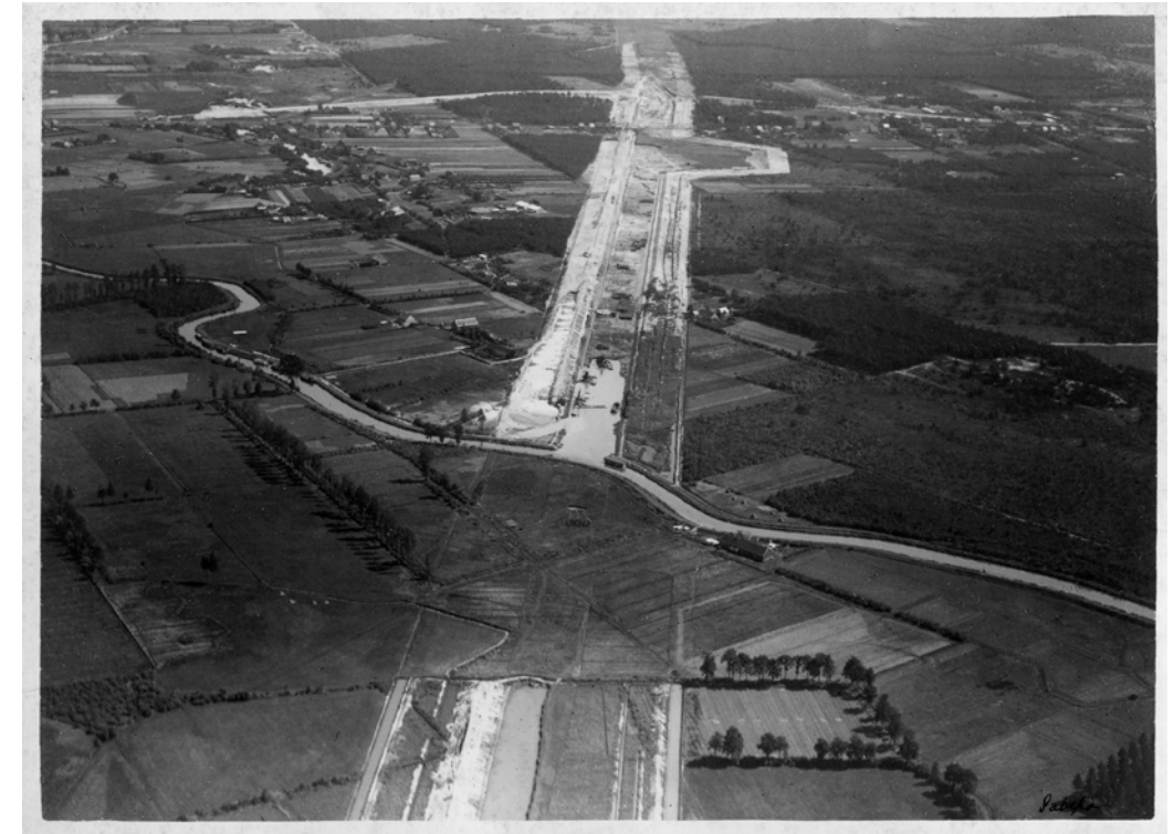
Aanleg van het Albertkanaal (1930-1939)
